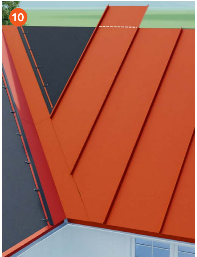
Placera plåten på taket och märk ut var den behöver kapas i överkant.
